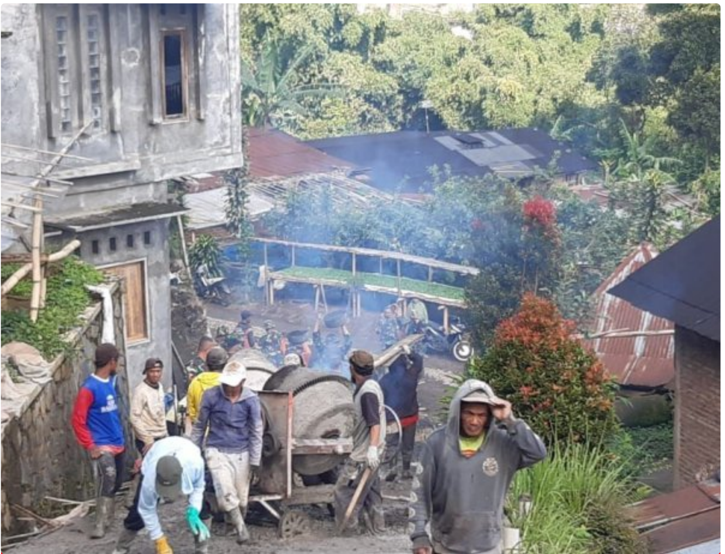
Satgas TMMMD dan Warga Bahu Membahu Kebut Pengecoran Jalan
